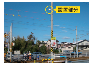
▲ 踏切設置 (全景)
